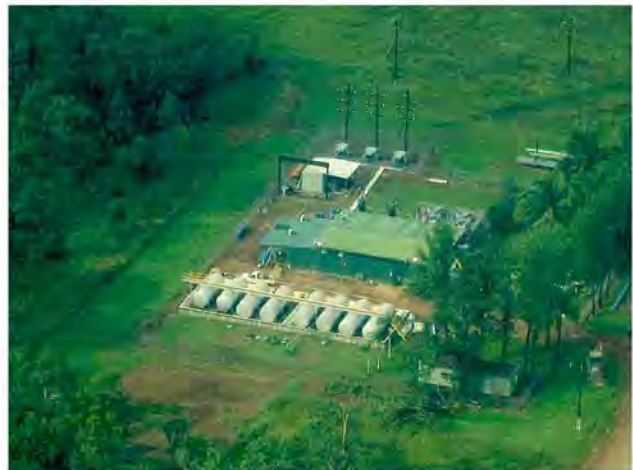
Wurrumiyanga Power Station
